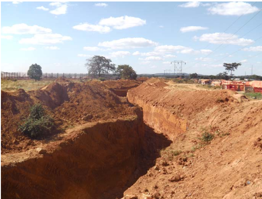
La tranchée creusée à Luisha par la Compagnie Minière de Luisha (COMILU), 20 avril 2012.
